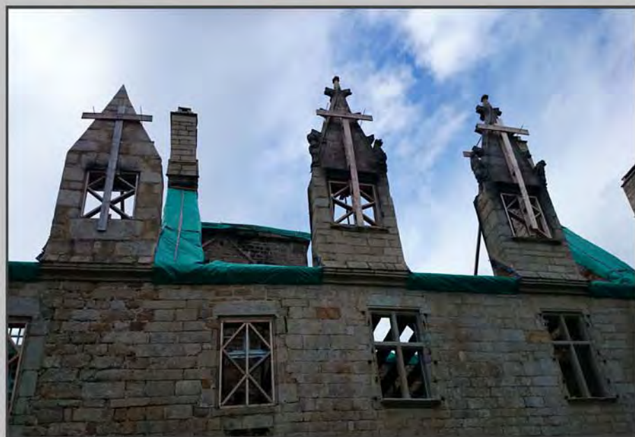
Linteaux de lucarnes fissurés
