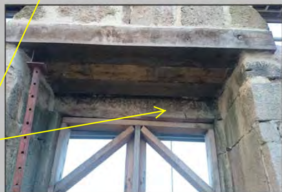
Linteaux de lucarnes fissurés
