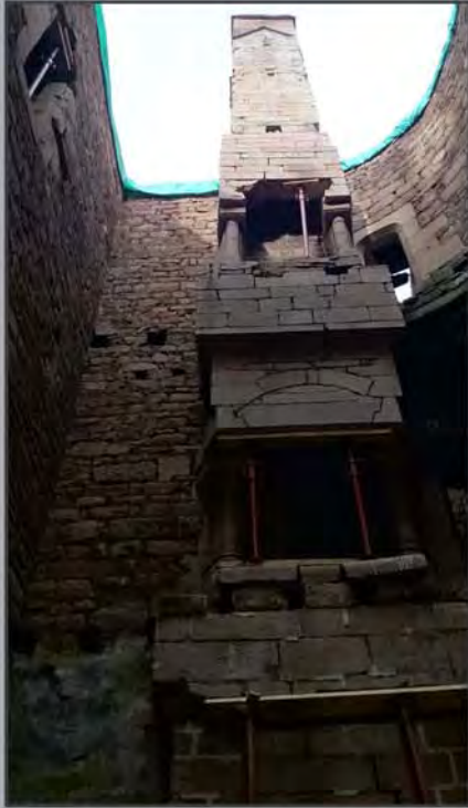
La tour ronde, seconde phase : renforcer le mur arrière dans le plan et fixer les éléments de cheminée.
