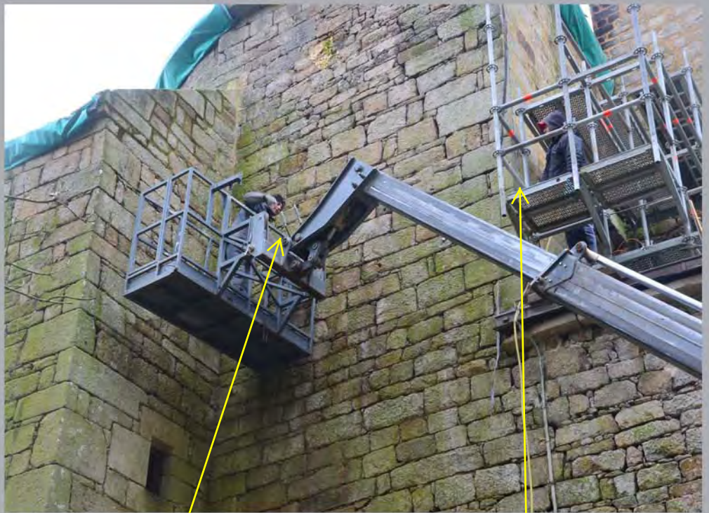
La tour ronde, seconde phase : renforcer le mur arrière dans le plan et fixer les éléments de cheminée.
